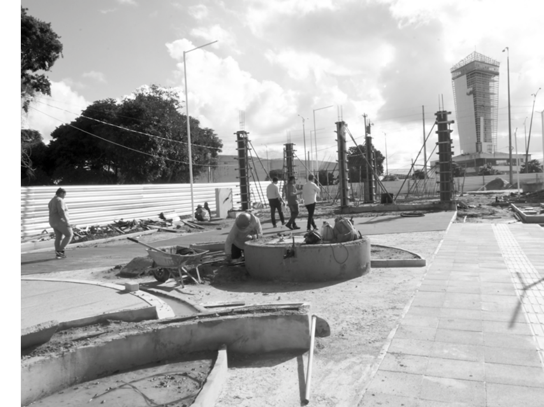
Governo está construindo o Boulevard dos Ipês que ligará o Centro de Convenções à praia
